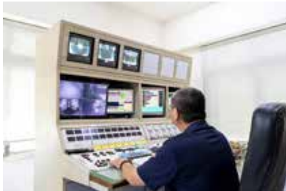
▲ 全台 28 間信賴廠區皆以科技調度室控管混凝土生產流程
