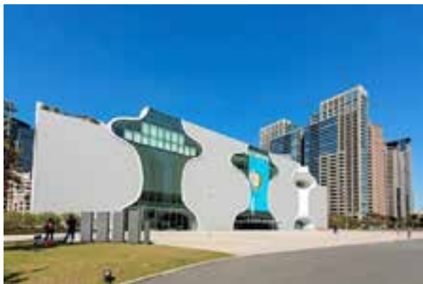
▲ 由日本建築大師伊東豐雄設計的臺中國家歌劇院，無樑柱的美聲涵洞與圓弧曲牆是最大特色，採用 6,000 磅 SCC 自充填混凝土。
