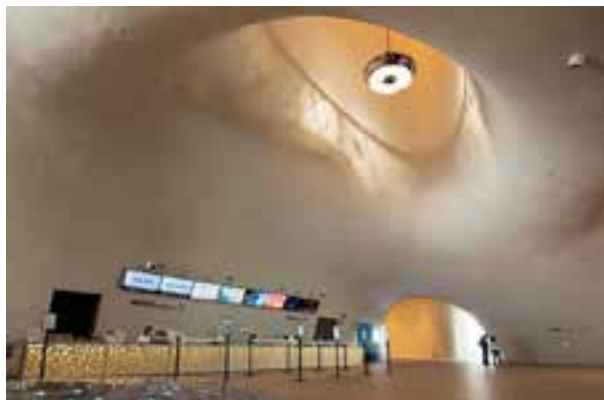
▲ 由日本建築大師伊東豐雄設計的臺中國家歌劇院，無樑柱的美聲涵洞與圓弧曲牆是最大特色，採用 6,000 磅 SCC 自充填混凝土。
