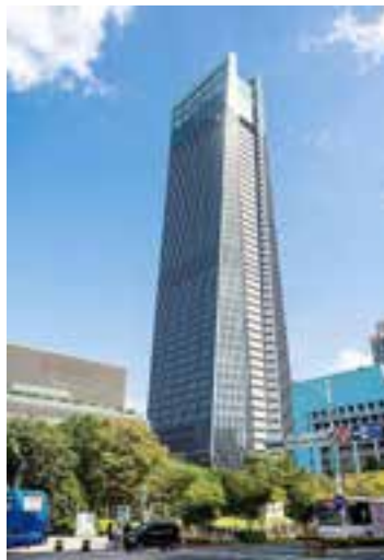
▲「南山廣場」採用國產建材 12,000psi 高強度混凝土，凌駕台北 101 的 10,000 磅。
