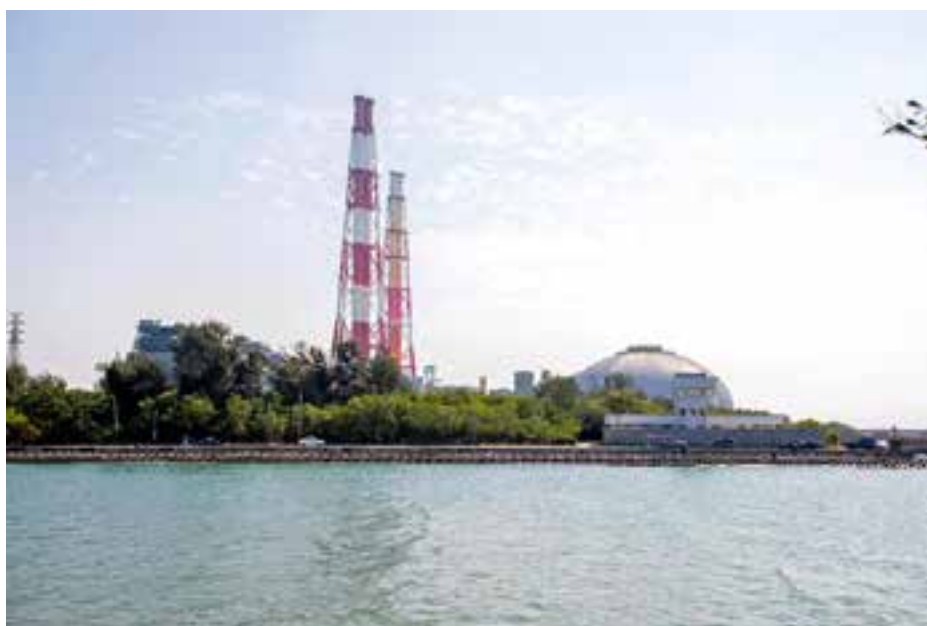
▲ 全國第一座離岸風電水下基礎廠房，信賴國產建材實業所具備大量澆築與協同調度能力，主體工程由國產建材實業岡山廠供應，還特別使用水中混凝土，以因應興達風電廠的特殊需求。
