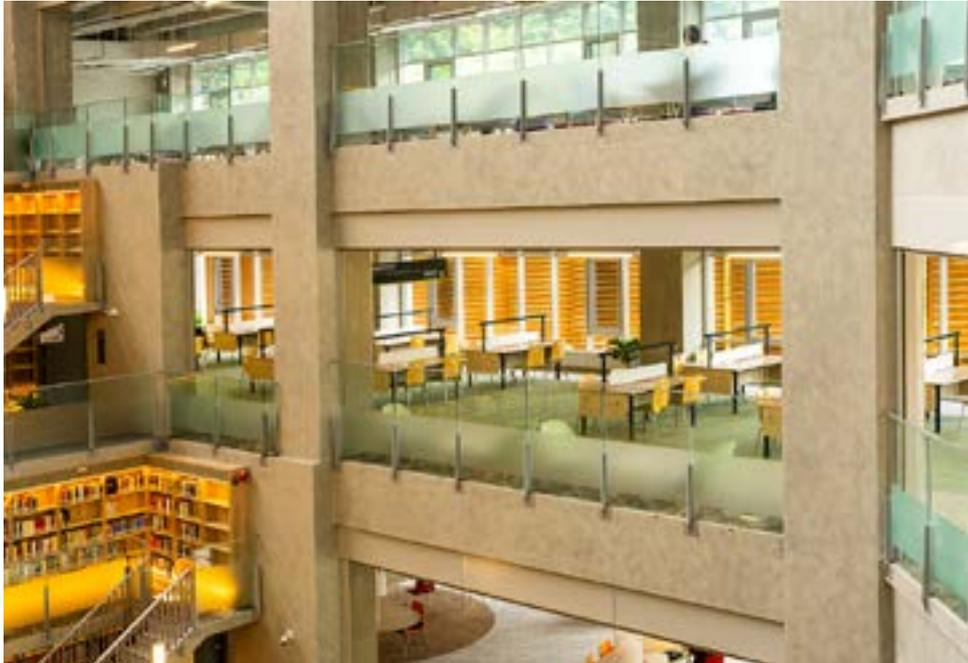
▲國產建材的6,000磅高強度清水混凝土，加上嚴謹細膩的清水模澆注工序，讓達賢圖書館室內外的樑柱更顯雋永高雅。
