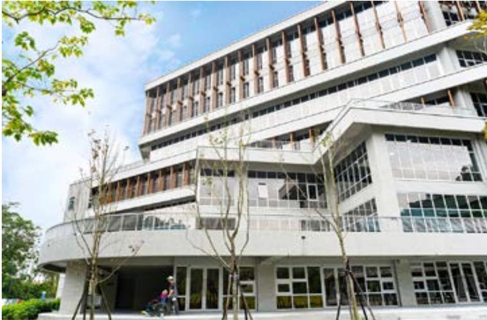
▲政大達賢圖書館坐擁綠意湖畔景觀，其主體結構、外牆與樑柱使用國產建材 6,000 磅高強度清水混凝土，外觀保留了混凝土原色，以預鑄工法做成一片片外牆，牆面更飾上純木紋紋理，粗獷中又帶著簡約美感。
