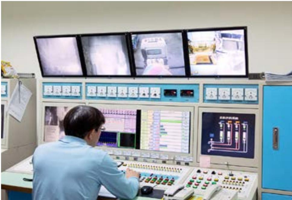
▲調度室監控混凝土與冰塊拌合情形。
