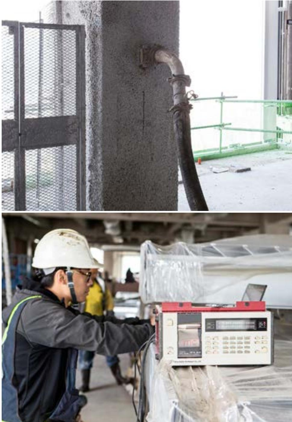
▲南山廣場建築結構採用高難度的「CFT 柱內灌漿工法」，成功挑戰最高 48 樓垂直泵送，獲台灣營建研究院同步驗證。
