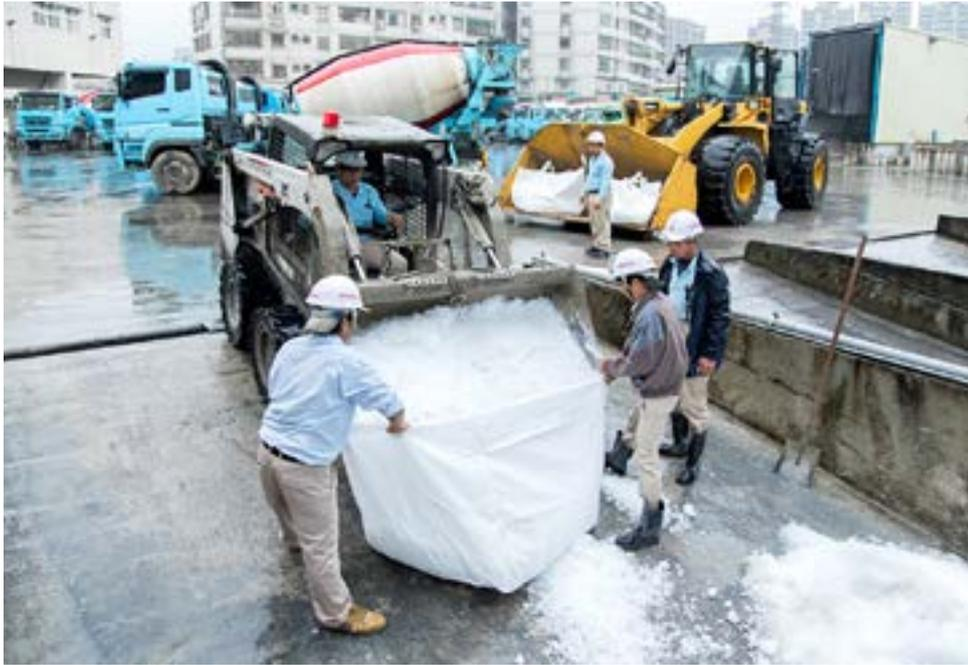
▲國產建材混凝土製程再創新！這次運用於榮總重粒子治癌中心的混凝土，動工前還進行混凝土「冰鎮」與實體模型試驗，以杜絕輻射外洩。
